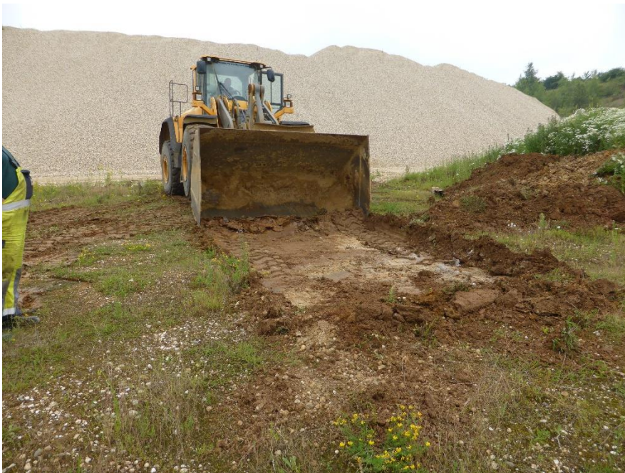
Foto2: Neuanlage eines Tümpels, Foto: Elmar Schmidt
